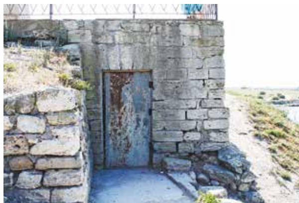
Рис. 7. Вход в помещение под колоколом с характерным оформлением. Вид с востока. 2018 г. (Фото Р. П. Смирнова).
